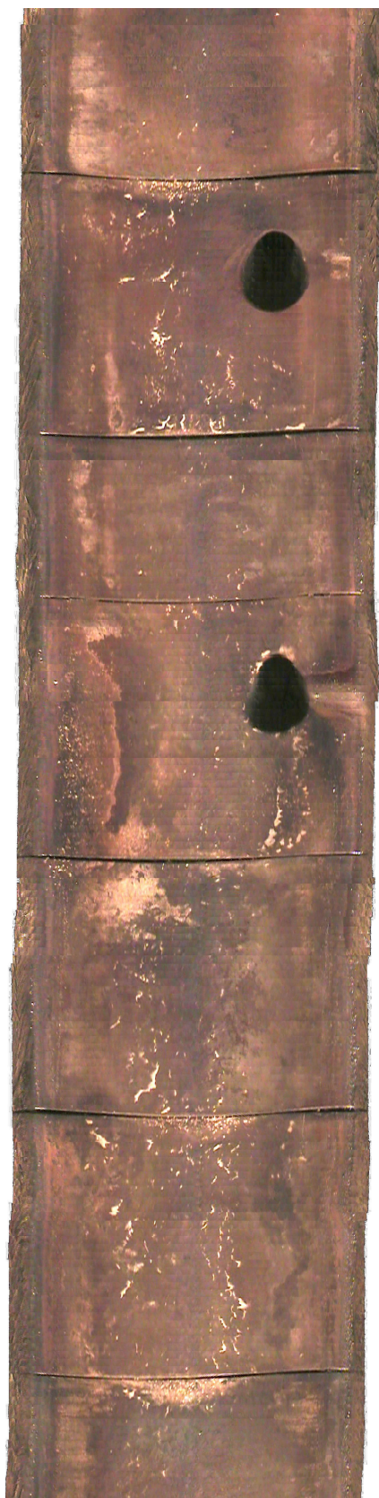
Obrázek 9.1: Výsledná mozaika - kameninové potrubí \varnothing 400 mm v délce cca 5.1 m.
