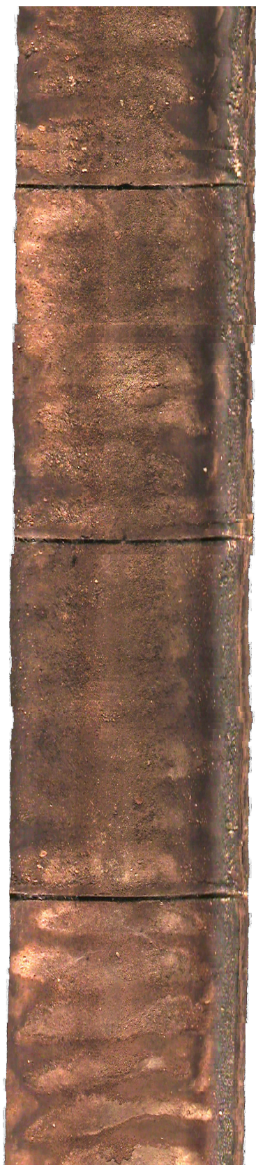
Obrázek 9.2: Výsledná mozaika - betonové potrubí \varnothing 300 mm v délce cca 3.9 m.
